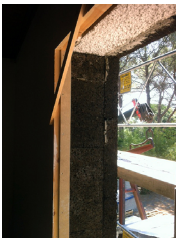
Aislamiento con corcho
